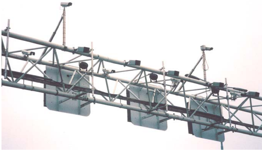
Figur 3.2 Portalmonterade kameror med runda "osynliga" IR- blixtar samt kontrollinstitutets (NMI) utrustning på översta balken
