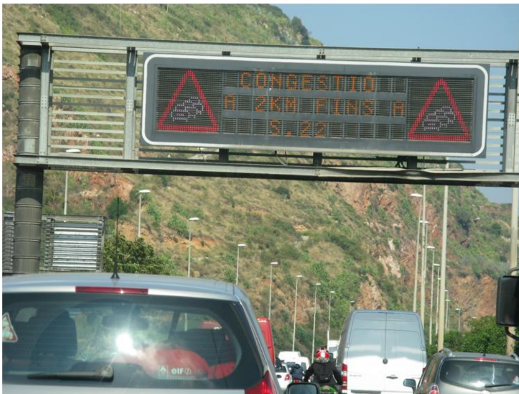
Foto: Exempel på VMS med tre textrader och möjlighet att visa olika vägmärken i färg bredvid texten. Texten syns bäst mörker. (Barcelona)
