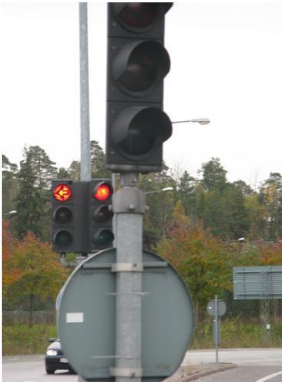
Foto: Den något tröga trafiksignalen (här med en trasig röd primärlykta) styrs från ett nedklottrat styrapparatsskåp
